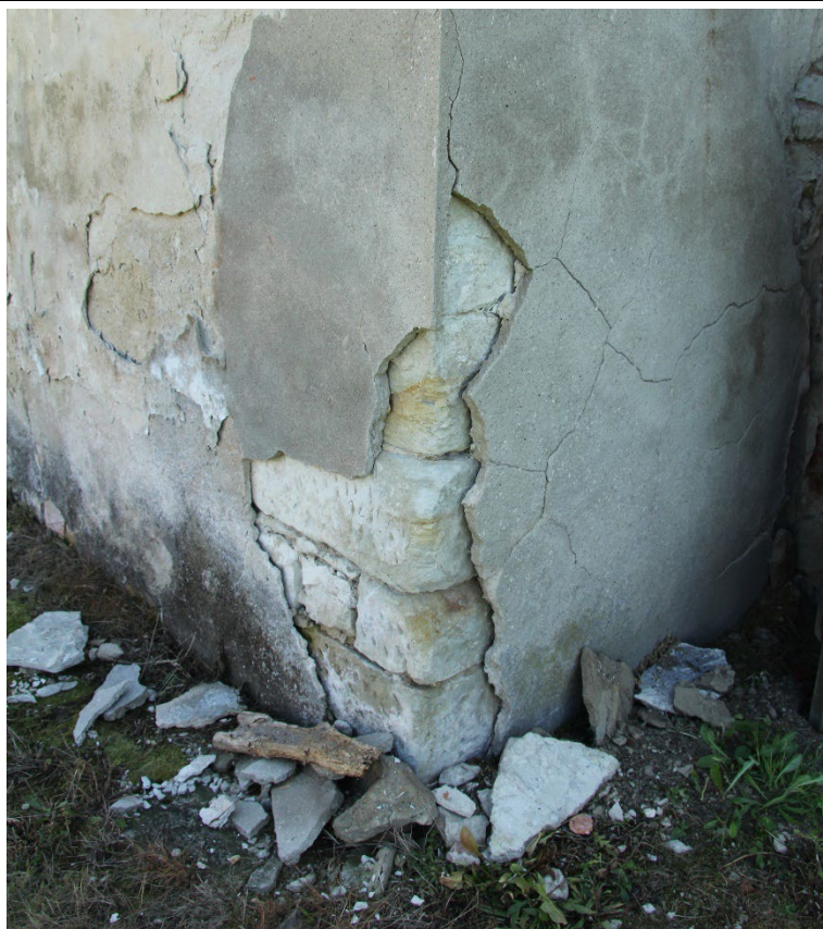
Pohled od severozápadu na armování severozápadního nároží sakristie. Foto: Jaroslav Skopec 2019.
