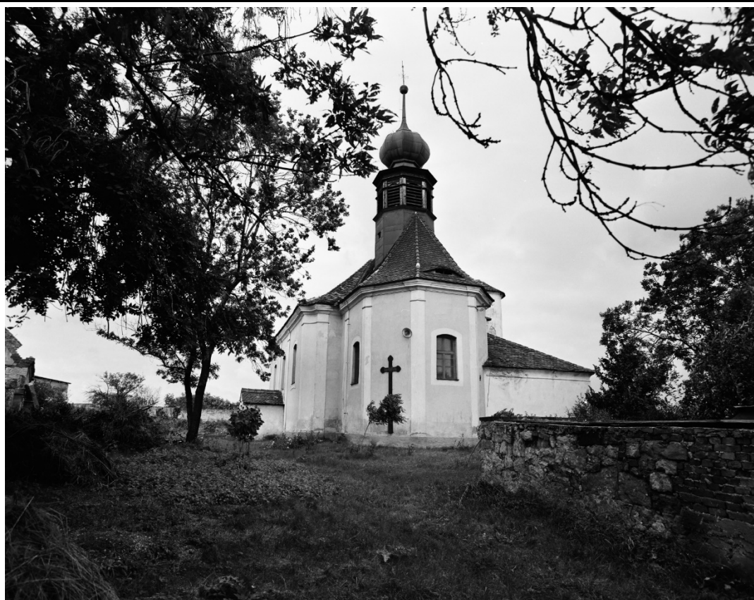
Celkový pohled na kostel od východu. Foto: 1994, sbírka negativů NPÚ ÚOP v Ústí n. L., sig. 105176.
