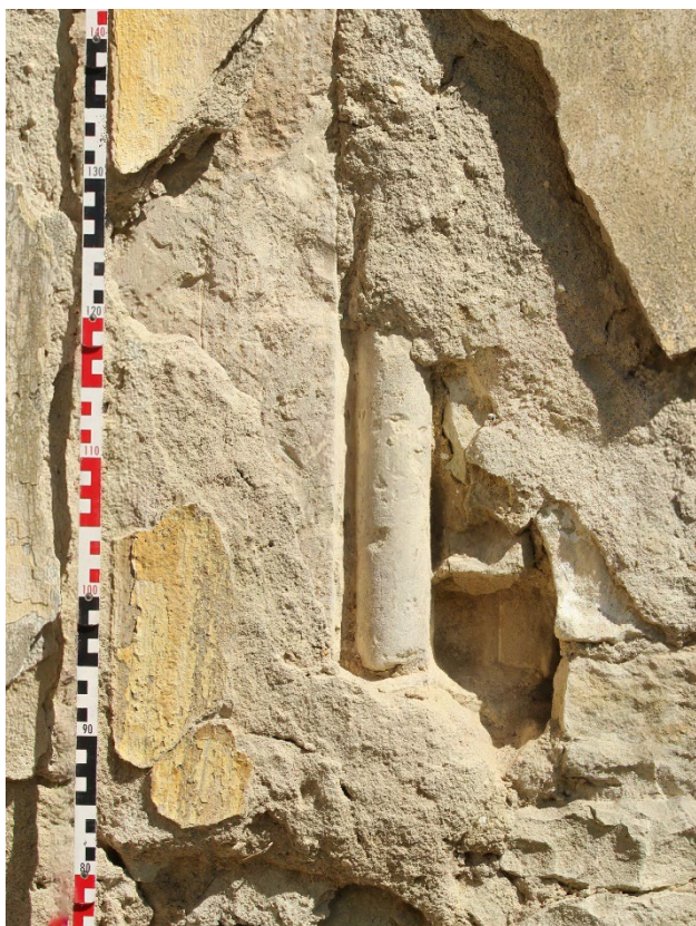
Detail západní stojky portálu. Foto: Jaroslav Skopec 2019.
