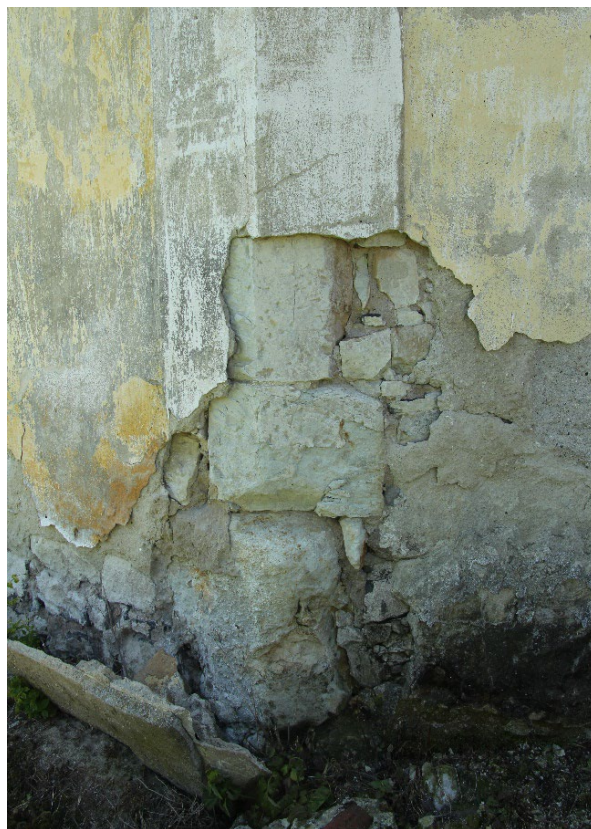
Detail armování v patě východoseverovýchodního nároží presbytáře. Foto: Jaroslav Skopec 2019.
