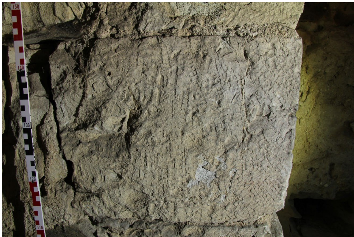
Detail kvádrů nárožního armování severovýchodního nároží lodi s patrnými stopami po opravě plošinou s plochými zuby. Foto: Jaroslav Skopec 2019.
