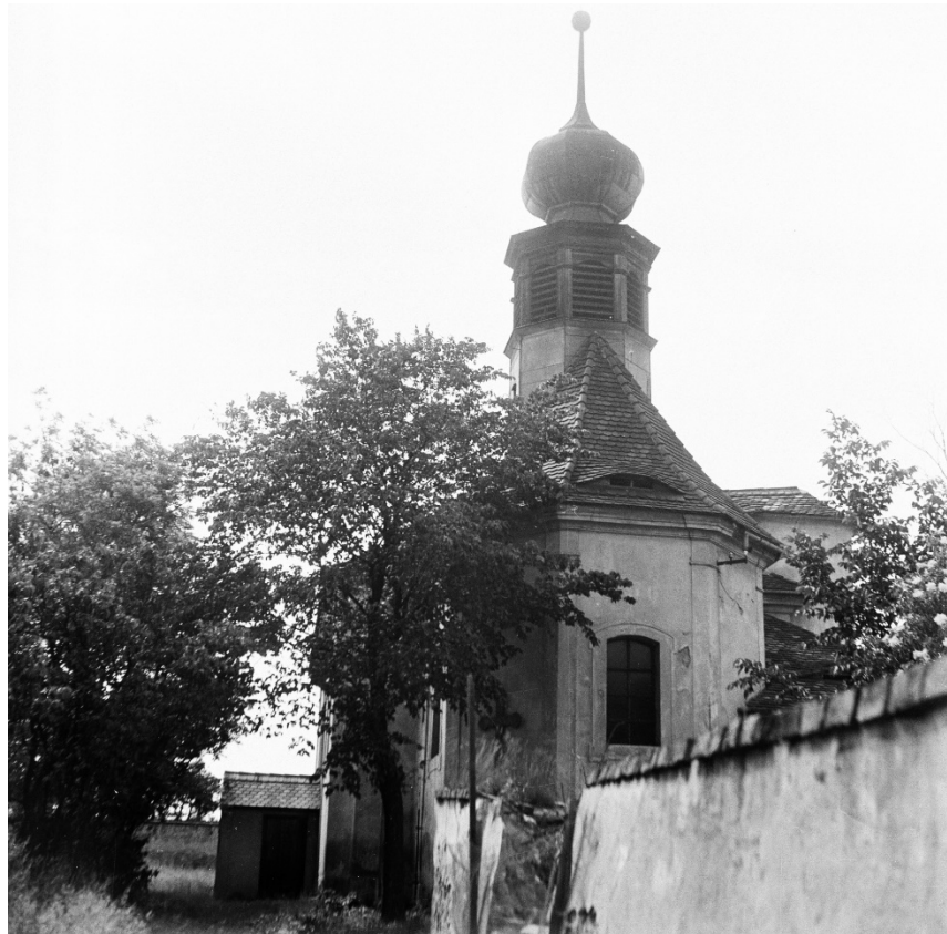
Celkový pohled na kostel od východu. Foto: 1963, sbírka negativů NPÚ ÚOP v Ústí n. L., sig. 9483.
