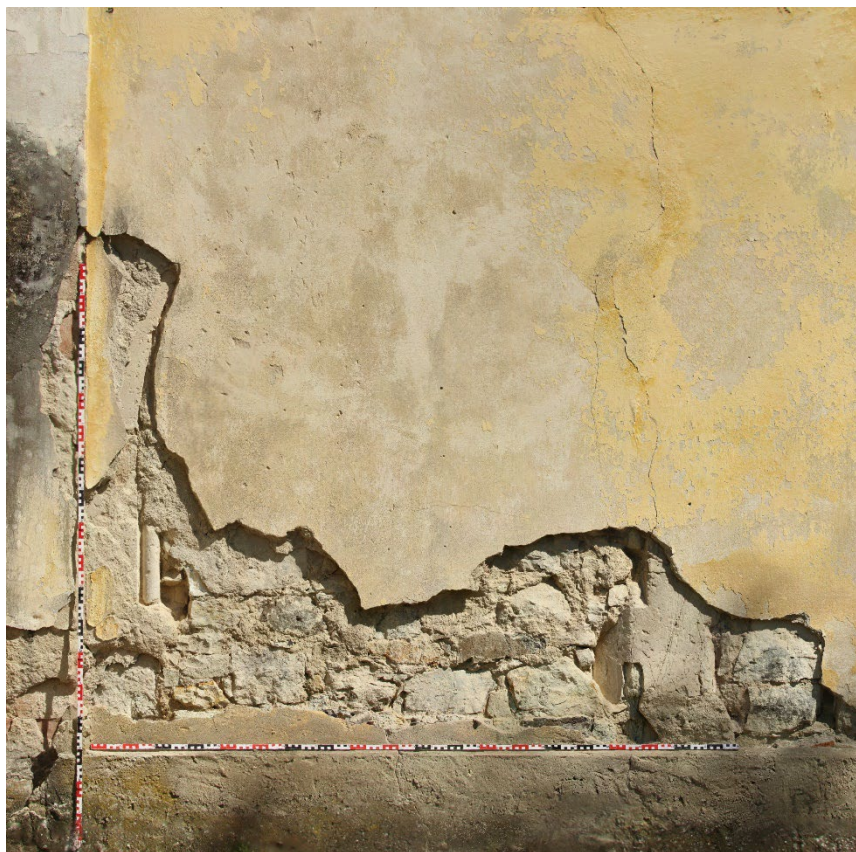
Čelní pohled od jihu na odhalené části středověkého portálu lodi po východní straně předsíně. Foto: Jaroslav Skopec 2019.
